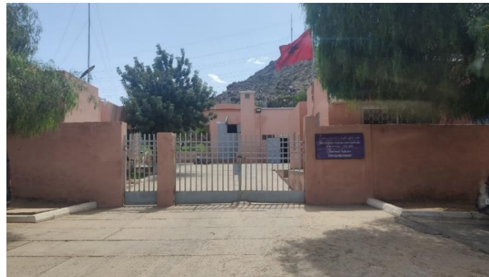
صورة 3: محطة معالجة المياه بقلعة السراغنة
